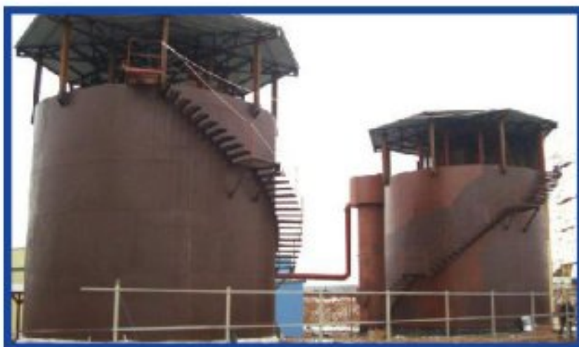
Строительство очистных сооружений
